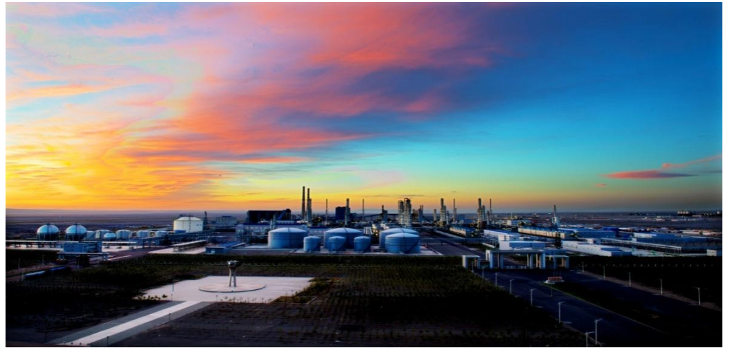
新能源工厂全景图
