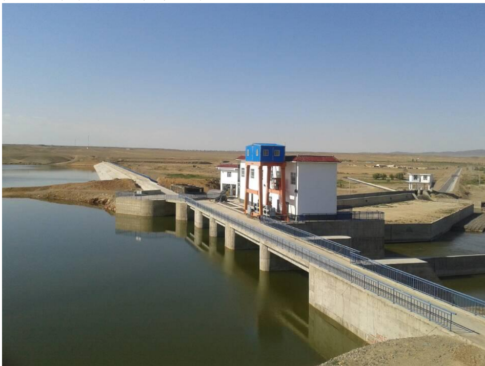
首部枢纽完工
