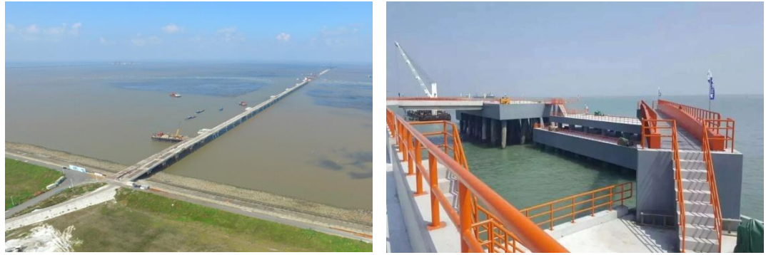
引桥、码头施工
