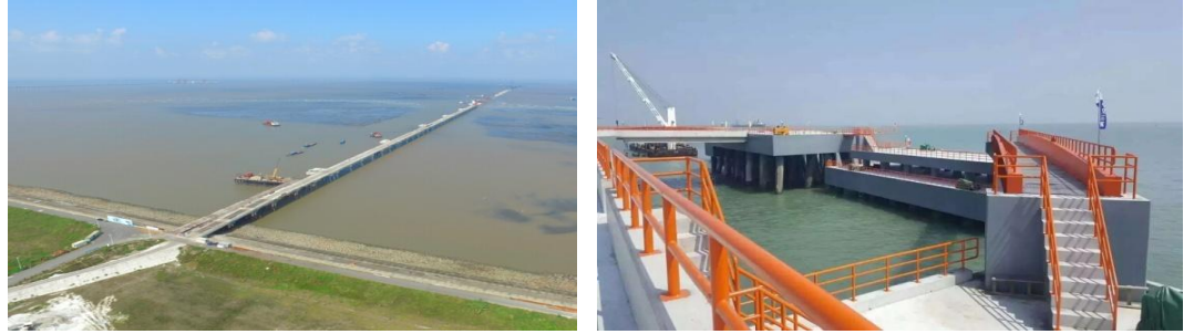
引桥、码头施工
