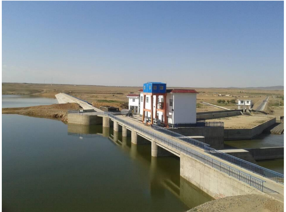
首部枢纽完工
