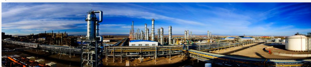
新能源工厂全景图
