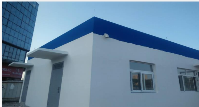
启东飞鹤加气站施工现场
