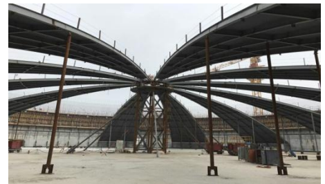
16 万方储罐建设
