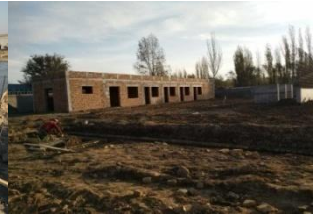
尼勒克加气站
