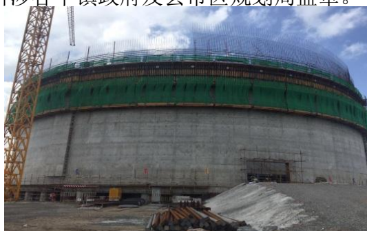
16万方储罐建设2
