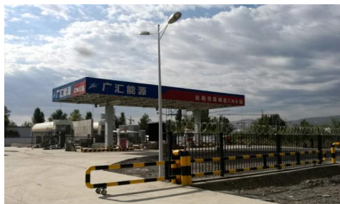
尼勒克加气站
