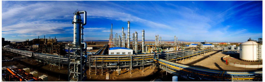
新能源工厂全景图
