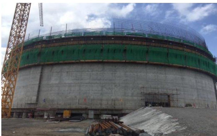
16万方储罐建设
