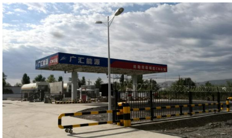
尼勒克加气站
